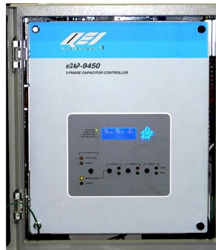
La lectura LED del panel frontal permite revisar rápidamente el funcionamiento del controlador sin necesidad de un ordenador portátil.
